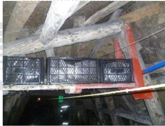
Şekil.4 Su Bekleme barajı
