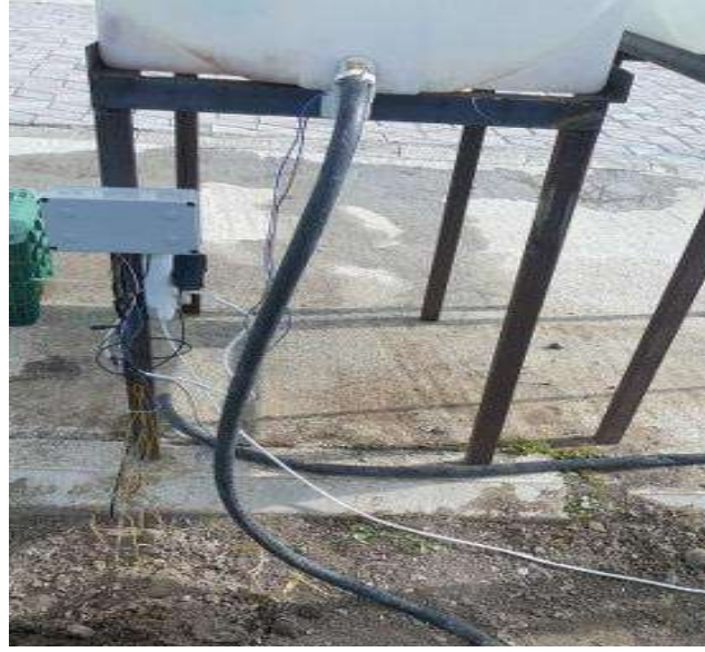
Şekil 2.3. Tasarlanan Sistemin Çalışma Alanına Kurulmuş Durumu
