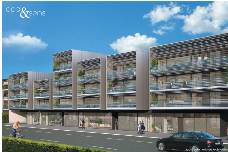
Façade sur l'avenue de Verdun
