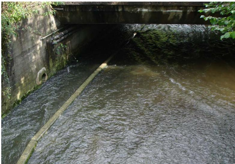
**Abbildung 12:** Glatte Betonsohlrampe im Aabach Horgen, 60 m von der Mündung entfernt, die nicht von Seeforellen überwunden werden kann.
