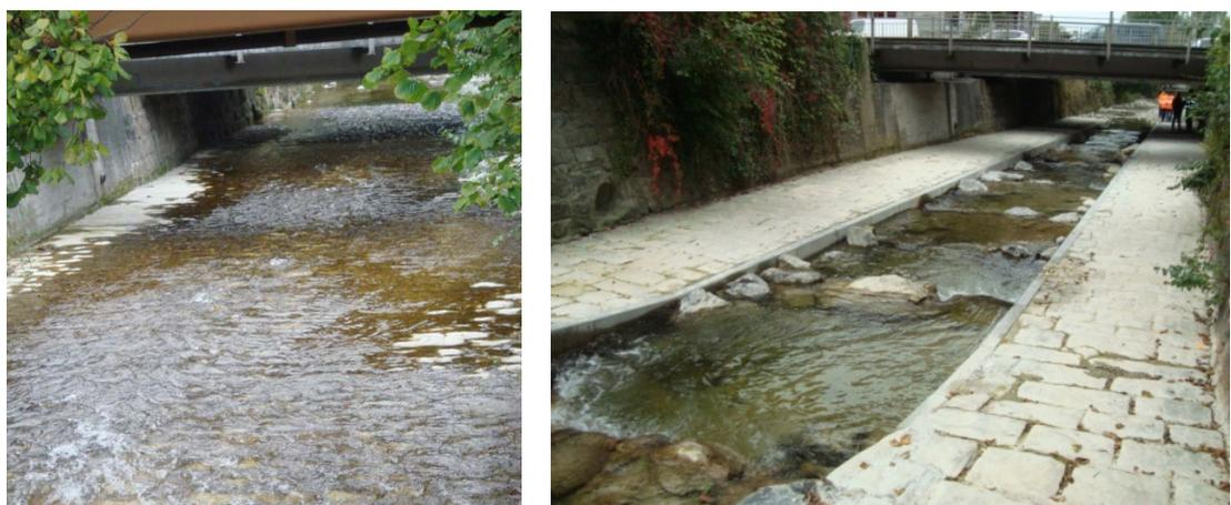
**Abb. 9:** Sohlgleite im Küsnachterbach vor und nach der fischgängigen Sanierung 2013. Die Massnahmen an vier Sohlgleiten 2011 und 2013 führten dazu, dass nun auch grosse, über 60 cm lange Laichtiere bis ins Dorfbachzentrum zu guten Laichplätzen aufsteigen.
