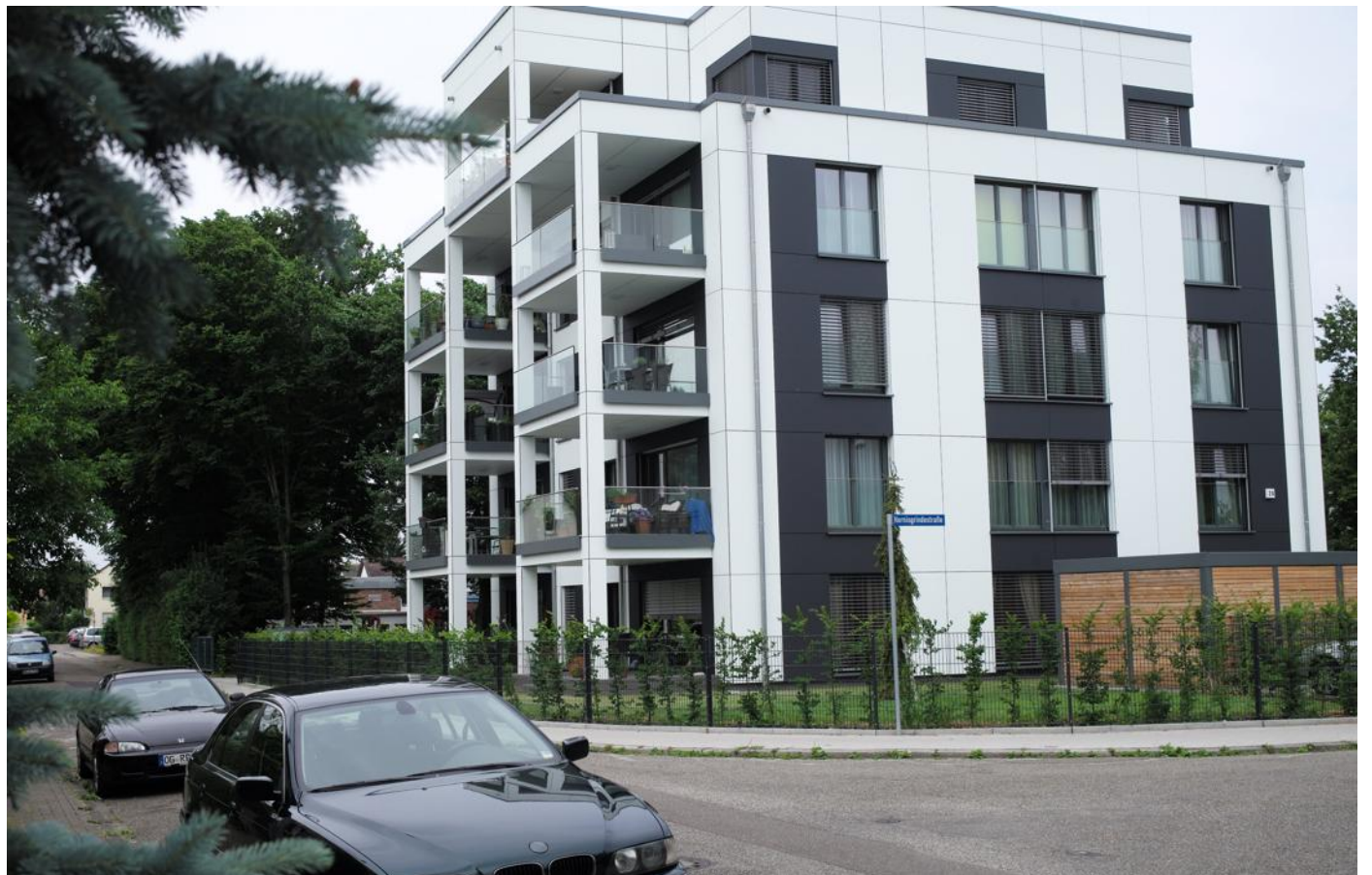
L'immeuble d'une hauteur de 17 mètres a été dessiné par l'architecte Hamid von Berg-Hadjoudj. Ses neuf logements offrent une surface habitable totale de 920 m 2 . PHOTO DNA - C. LUTZ-SORG
