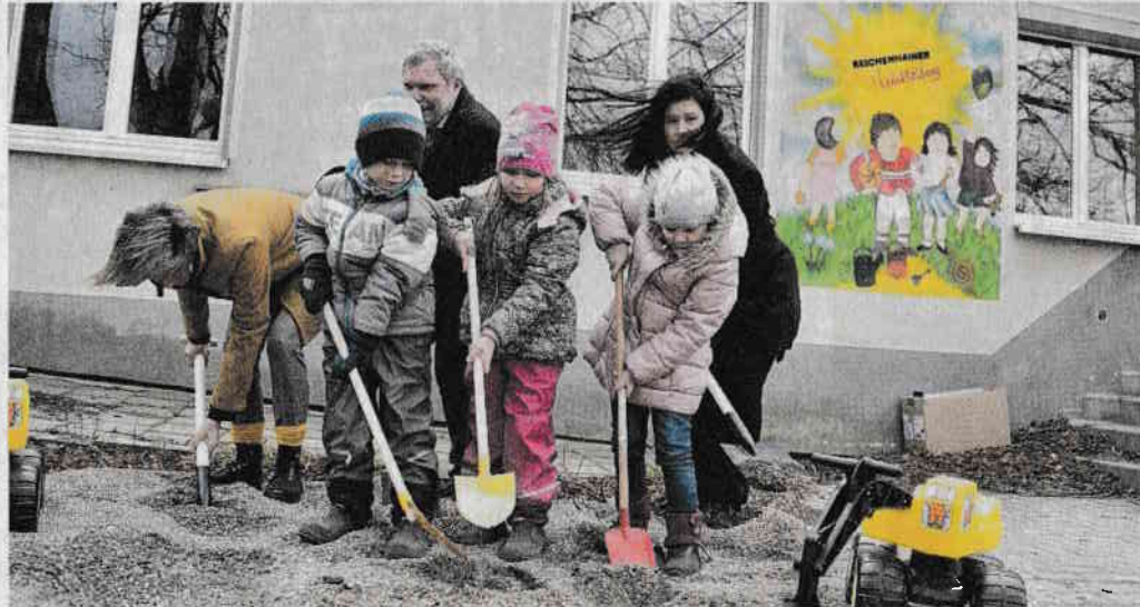
Gemeinsam mit den Kindern setzte Barbara Ludwig (li.) den ersten Spatenstich.
