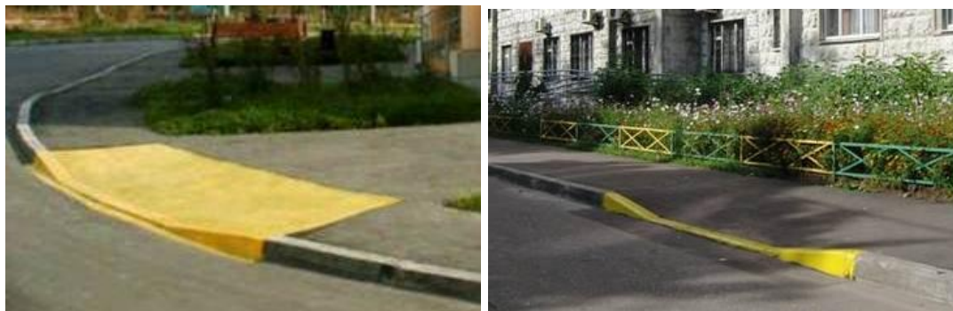
Бортовой камень в местах пересечения тротуаров с проезжей частью
