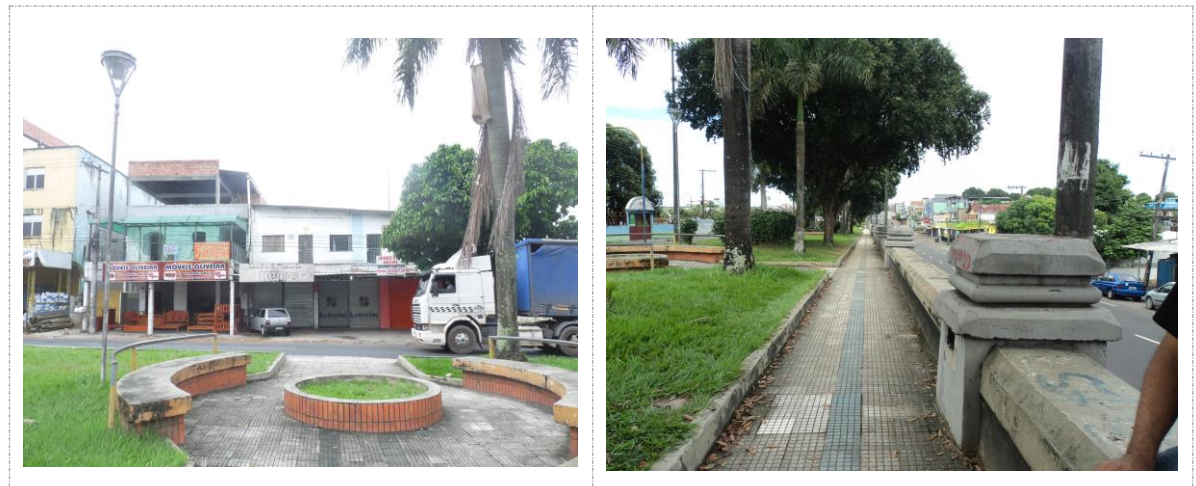
Figura 24– Fotografia ilustrando o canteiro central do seguimento nº 3 da via analisada
