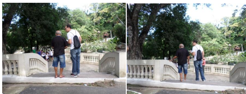
Figura 53: Foto do momento em que o idoso faz ressalva às condições da escada (Sujeito 01-A).
