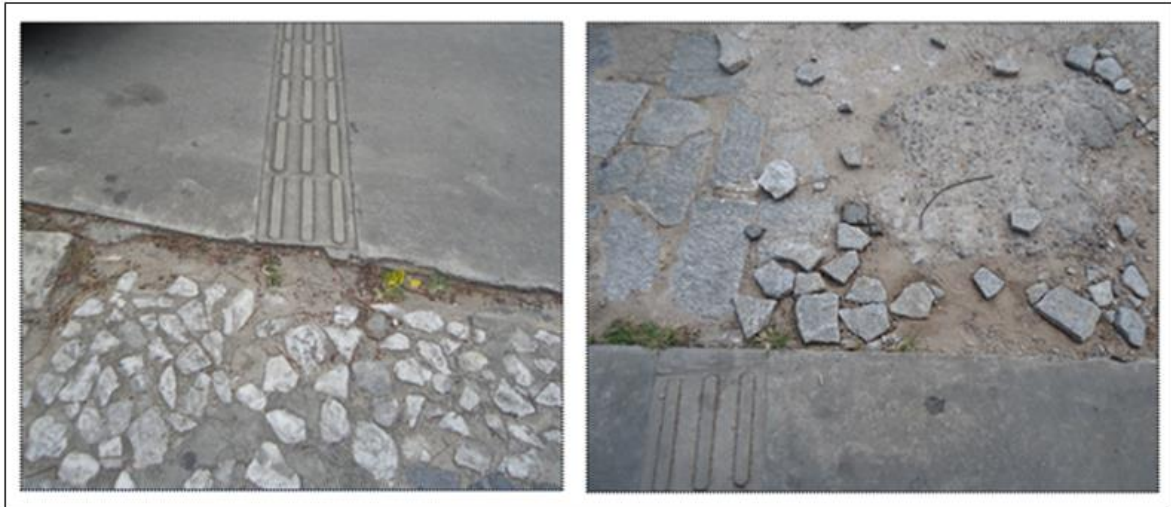
Figura 19. Uma calçada com piso direcional sem continuidade nas demais calçadas.
