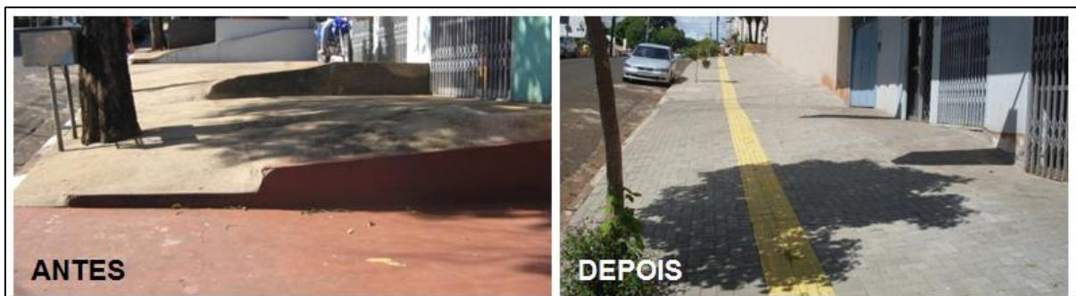
Figura 5. Retirada de degraus entre testadas.
