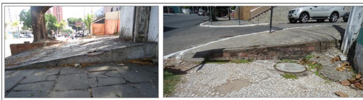
Figura 16. Exemplos de calçadas com desníveis de uma calçada para outra.
