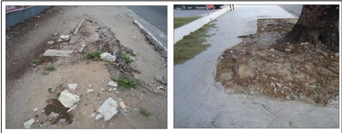
Figura 25. Exemplos de árvores e toco de árvores que tornaram-se obstáculos para pedestres.
