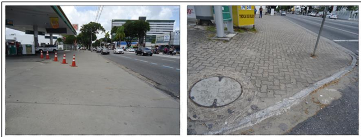
Figura 23. Exemplos de postos de gasolina que rebaixam totalmente as calçadas, criando possibilidade de conflito entre pedestre e veículos.
