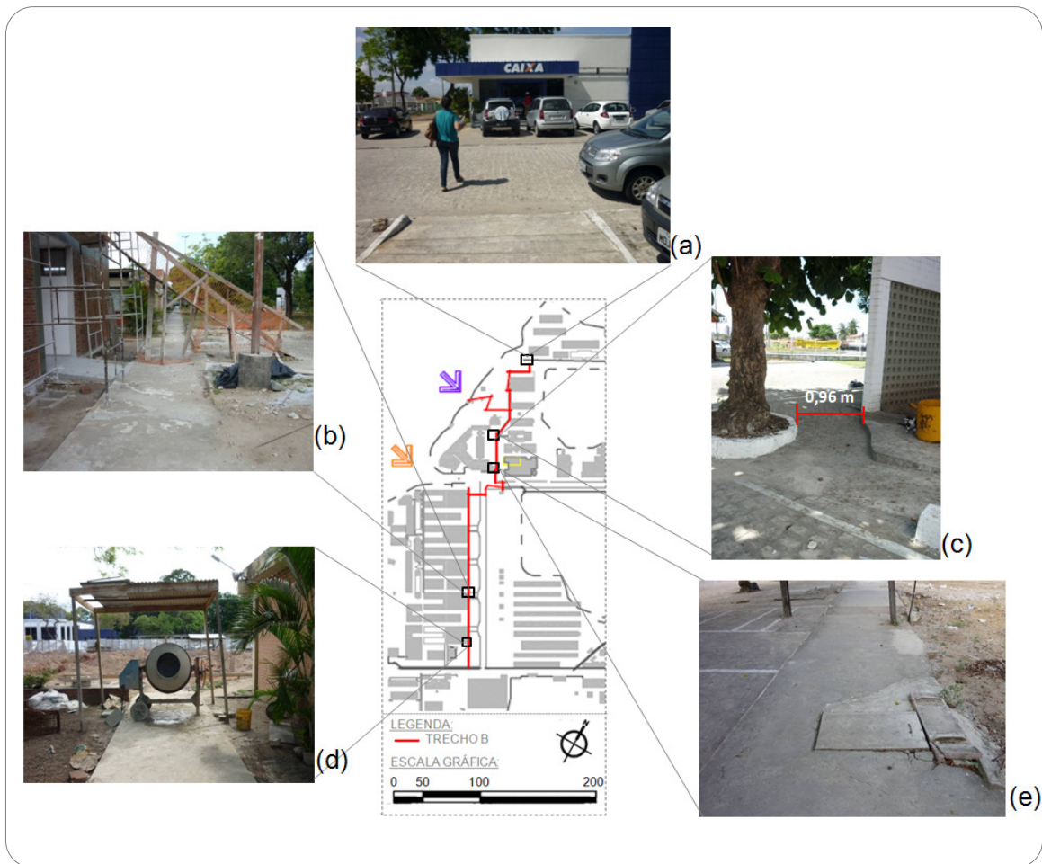
Figura 31: Quadro de imagens do Trecho B – a) ausência de faixa de travessia junto a CEF; b) obra interrompendo o percurso; c) menor faixa livre de circulação do trecho; d) obra sem sinalização obstruindo o percurso; e) tampa de concessionária provocando desnivelamento do piso.
