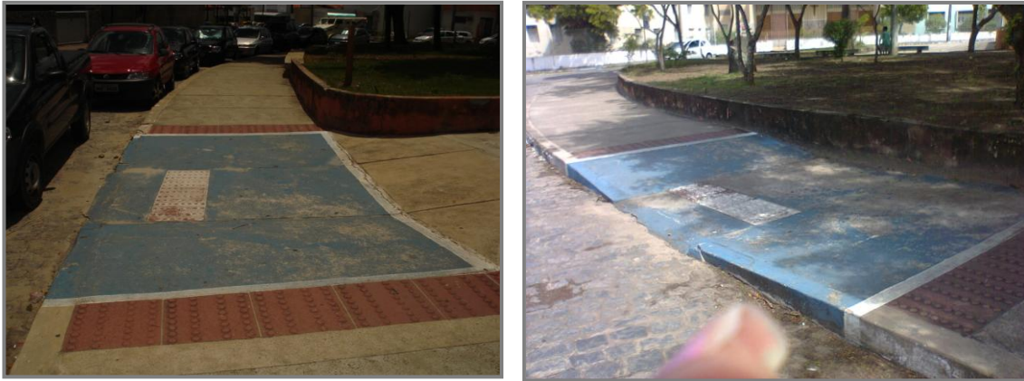
Figuras 51 e 52. Fotos das rampas da Praça São Gonçalo.
