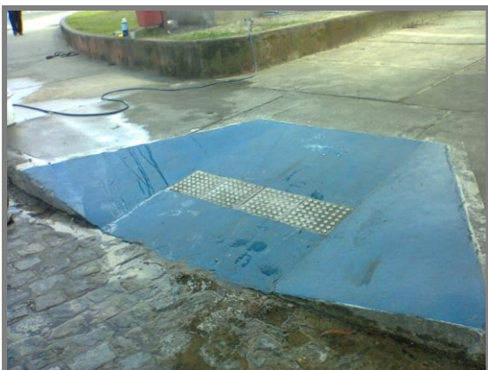
Figura 41. Foto do rebaixamento de guias
