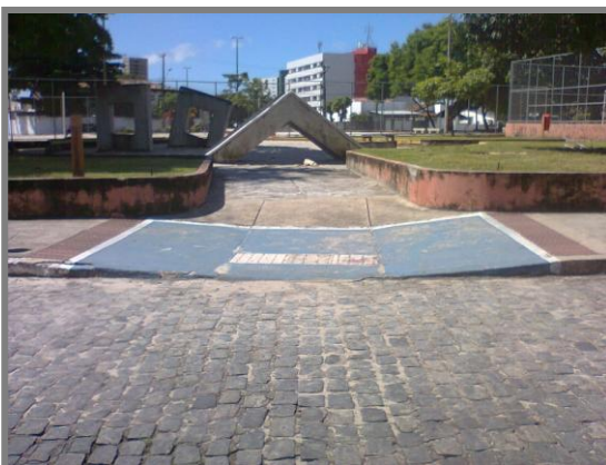
Figura 42. Foto do rebaixamento de guias
