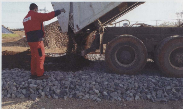
PLANCHES D'ESSAI. Trois séries d'essais ont affiné la conception technique des quatre horizons du sol qui concilie la portance, le drainage et la bonne santé du gazon.
