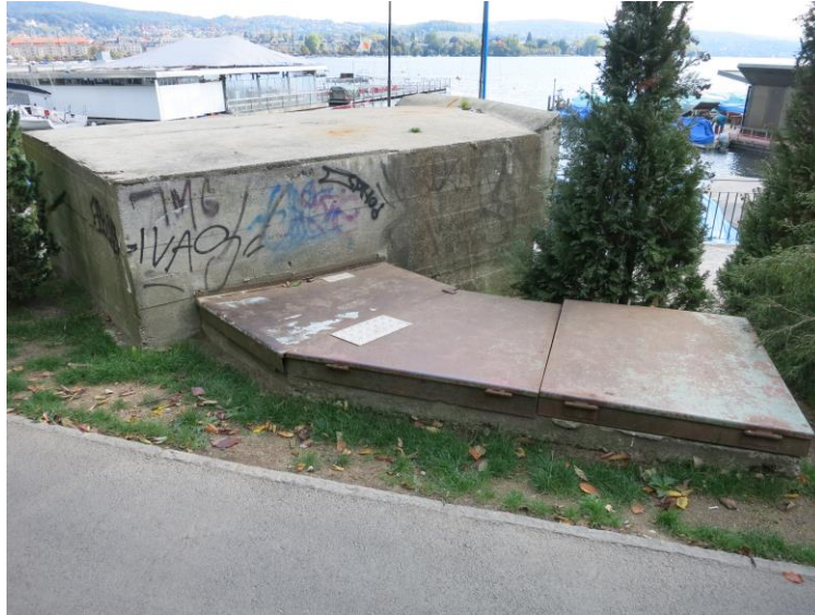
Bunker Zürich Enge
