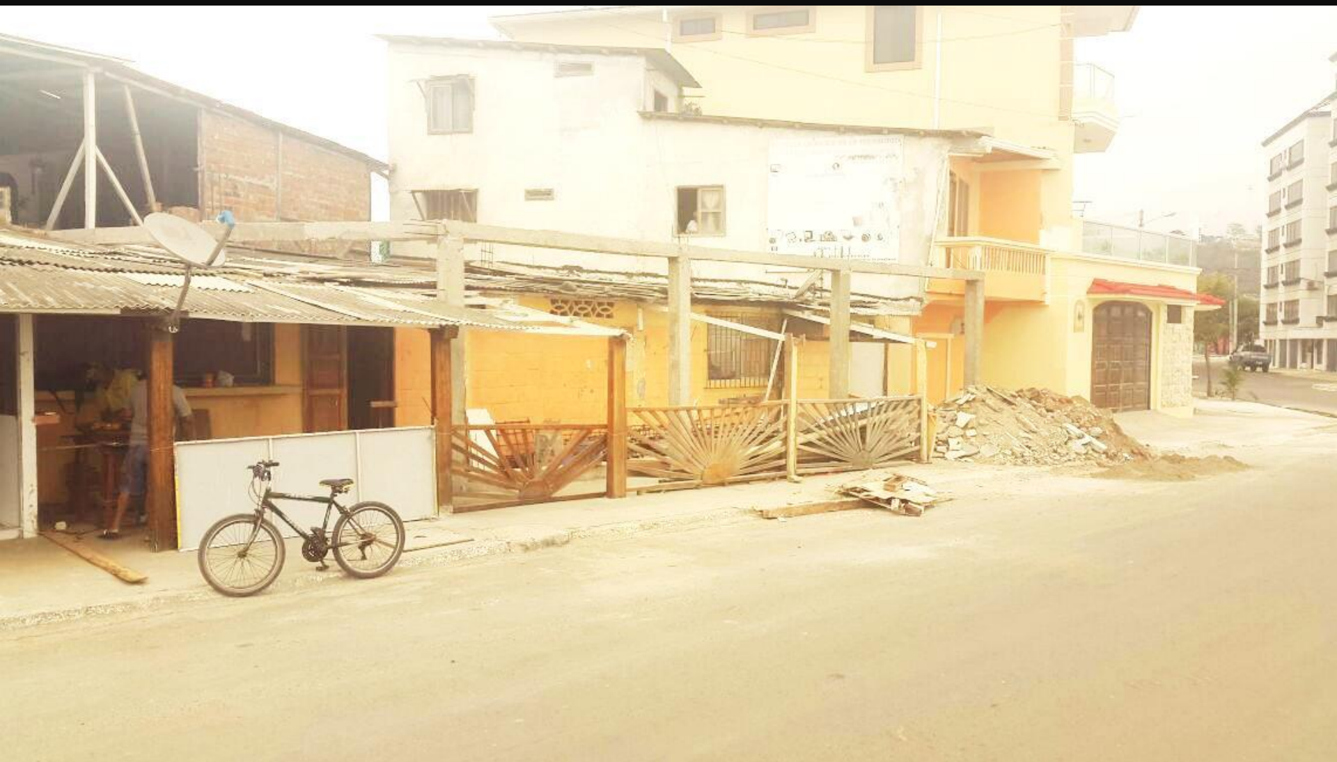
Restaurante Sunrise – Bahía de Caráquez (vista frontal, afectación parcial)
