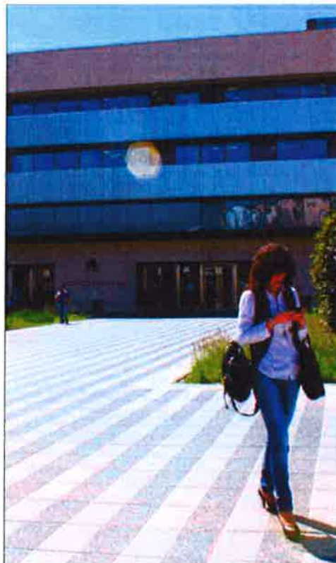
Fachada de la Ciudad de la Justicia de Castellón. EUGENIO TORRES
