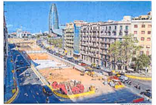
Vista de la boca del túnel de la calle Castillejos
