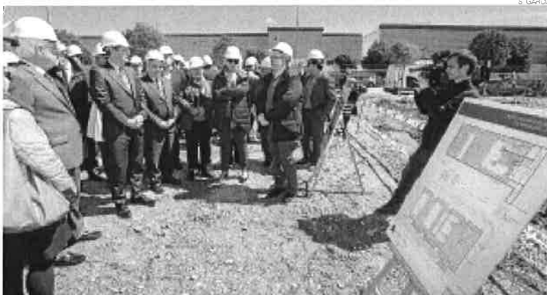
► Un técnico explica el proyecto, durante la visita del ministro en funciones y el alcalde a las obras.
