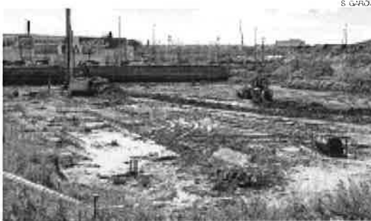
► Operarios y máquinas colocan pilotes de los cimientos.
