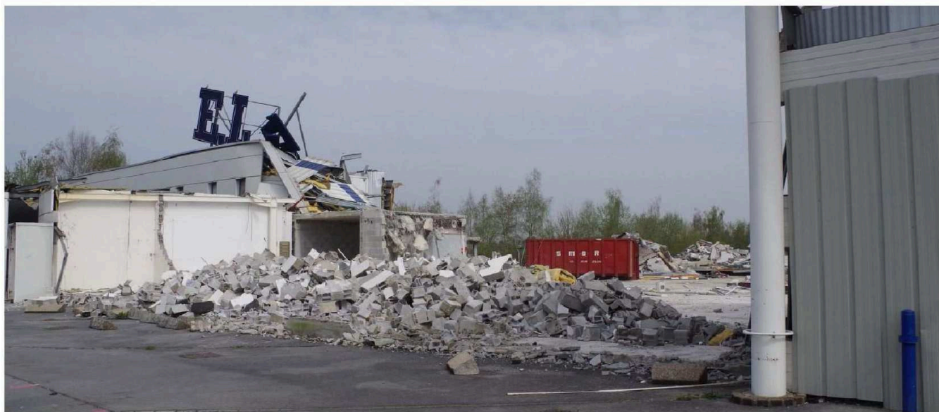
L'ancien magasin Leclerc, rue de Cambrai, a été démolé en avril 2015.
