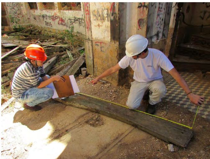
Figura 6 – Medição de cambota de cobertura da Igreja de São Joaquim da Grama. Arquivo do autor.
