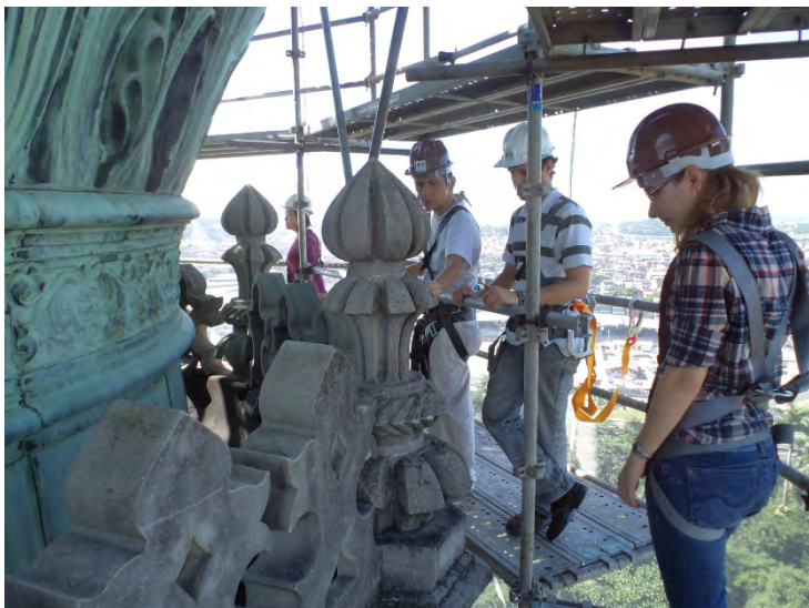
Figura 3 - Visita de equipe técnica da Astorga a uma obra da empresa MVIANA nos torreões na FIOCRUZ. Arquivo do autor.
