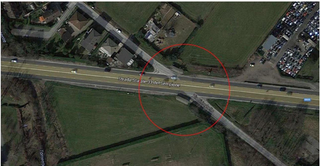
FOTO 2: Sottopasso su SS33 all'altezza di via Biringhello.
