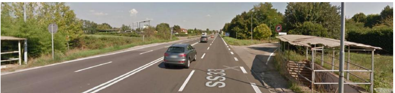
FOTO 3: Sottopasso su SS33 all'altezza di via Biringhello.
