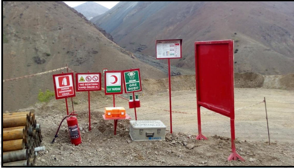
Şekil 4. Yangın tüpü, göz duşu, ilk yardım çantası ve acil durumlarda aranacaklar listesi
