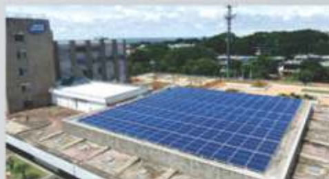
CAIXA CULTURAL (Brasília - DF) 101,76 kWp
