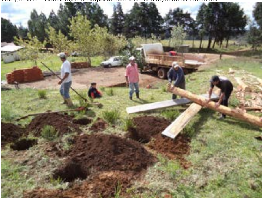
Fotografia 3 – Construção do suporte para a caixa d'água de 20.000 litros
