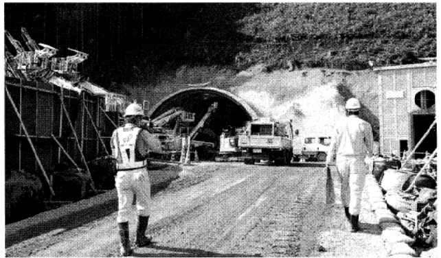
国道57号北側復旧ルート「二重峠トンネル」坑口付近(阿蘇工区)。工事は24時間態勢で進んでいる
