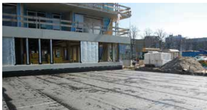
Extra beschermingslaag wordt aangebracht op Novacell.
