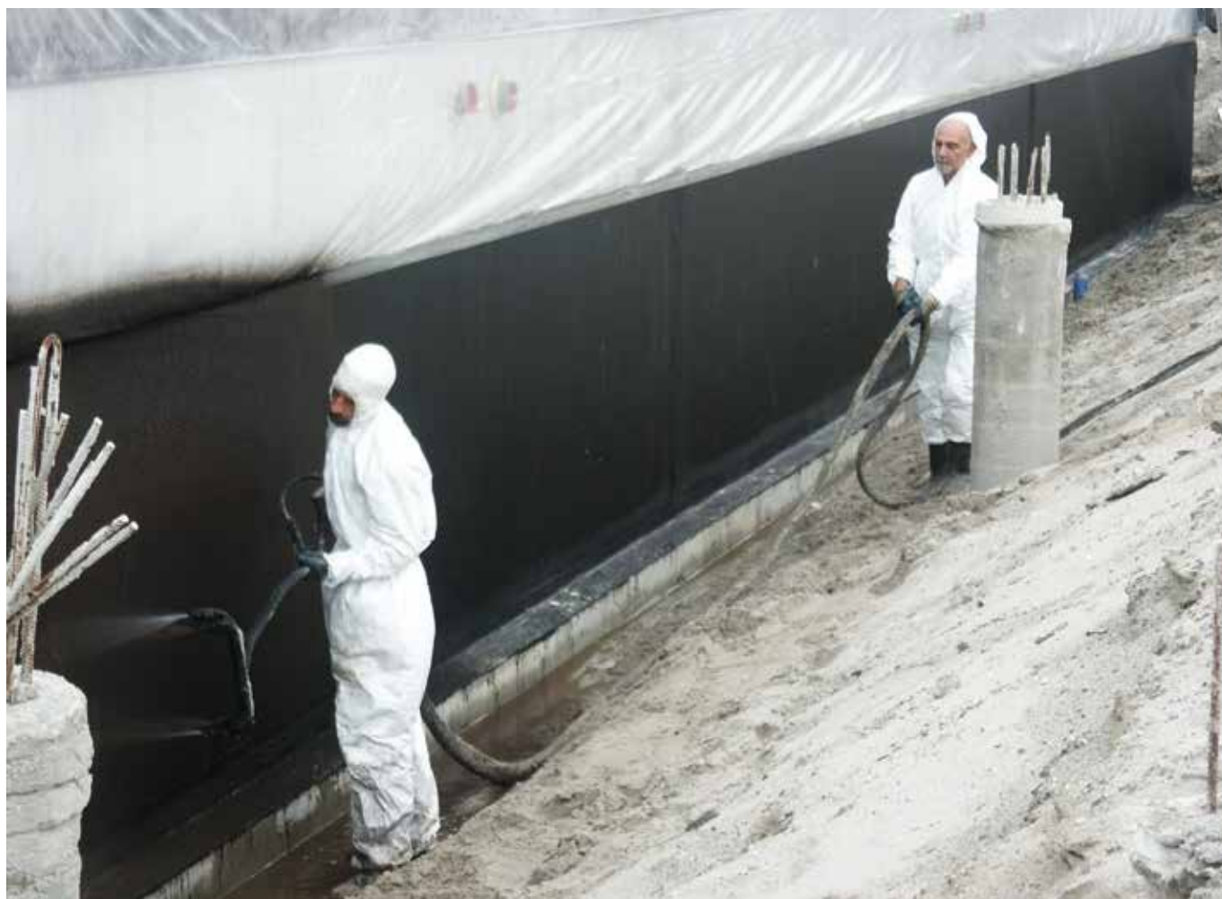
Novacell aanbrengen op wanden.
