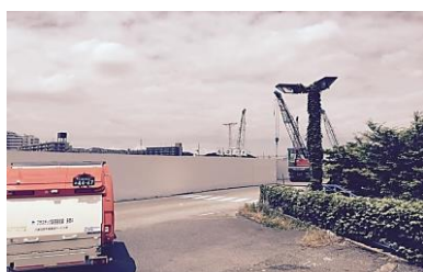
梶ヶ谷非常口工事現場
