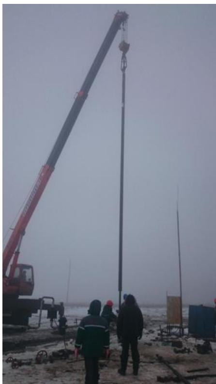
Рис. 4. Монтаж ЭЦН
