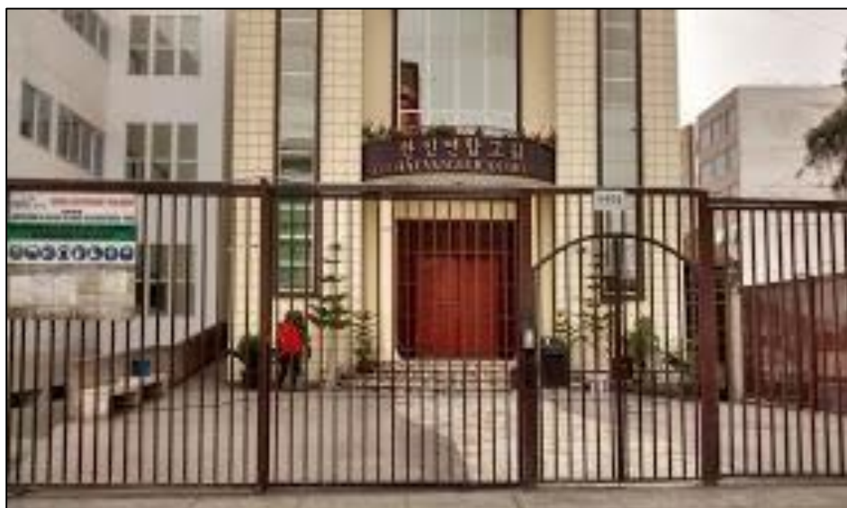
Iglesia evangélica Unión Church, ubicada en el distrito de Miraflores, Lima.
