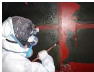
スクレーパによる塗膜剥離除去の状況
