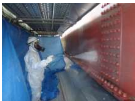
スプレー塗装状況
