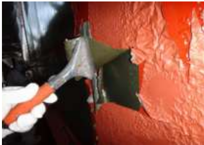
スクレーパによる塗膜剥離除去の状況
