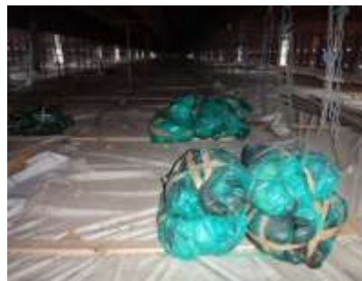
剥離塗膜と養生シート等の廃材
