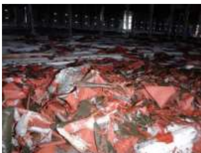
剥離除去した塗膜の状況
